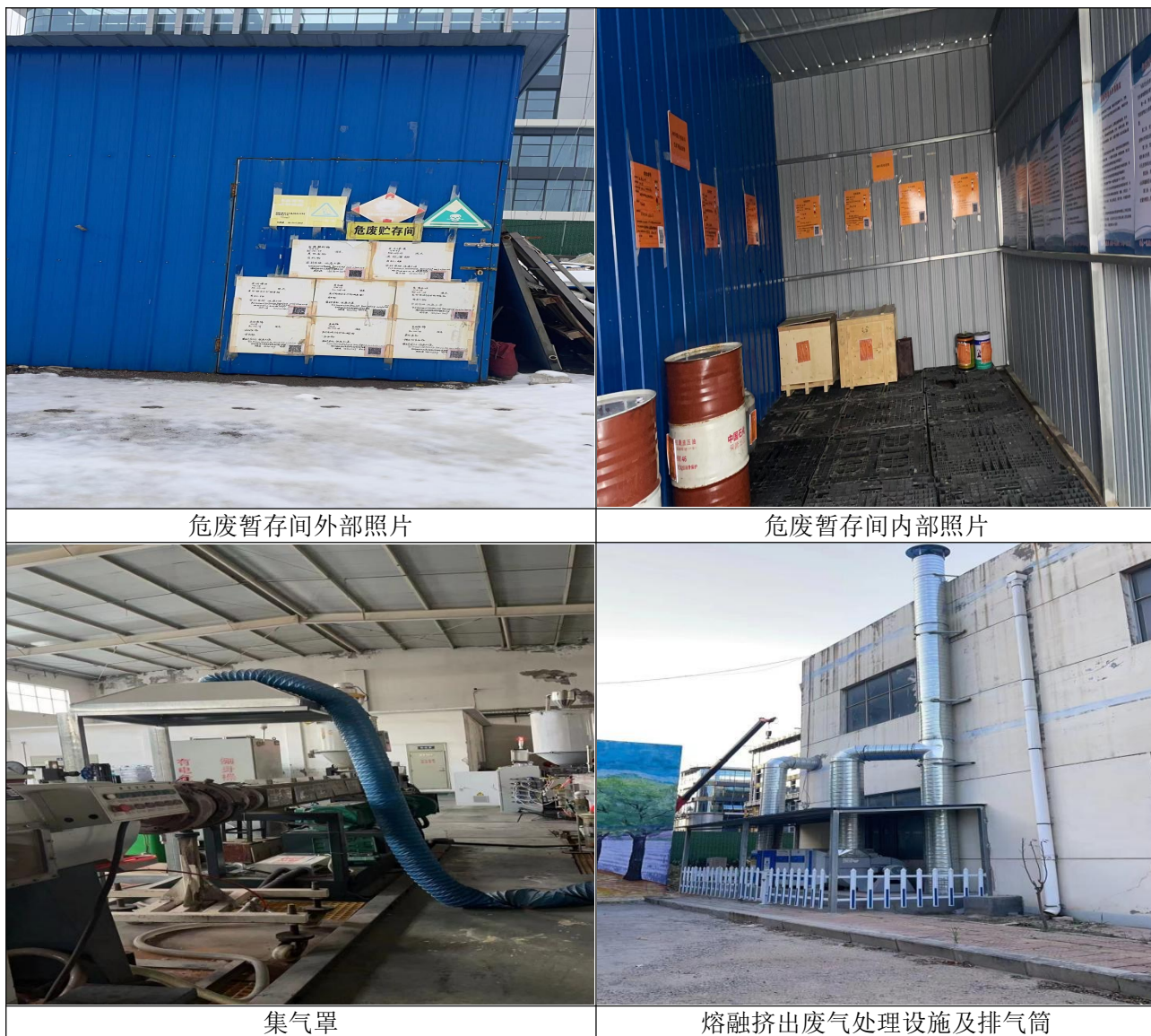
图 3.3-1 项目建设现状照片
